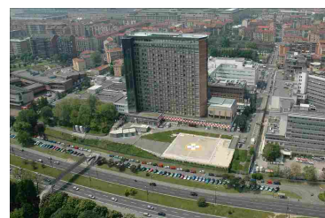
Torino - CTO: braccio staccato e distrutto in fabbrica recuperato dopo 12 ore di intervento
